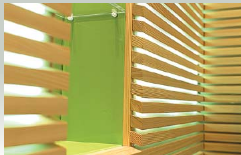
Gäste-WC Wandverkleidung aus Lärche mit indirekter Beleuchtung, Deckensegel als Sternenhimmel in Weißlack, Wandnischen mit Creacolor ESG-Glas in „Lemon“. Eigene Fertigung!
