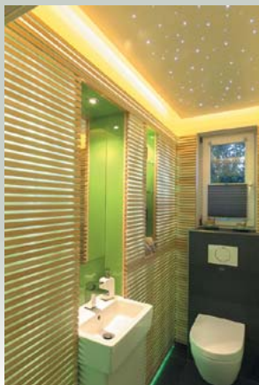
Gäste-WC Wandverkleidung aus Lärche mit indirekter Beleuchtung, Deckensegel als Sternenhimmel in Weißlack, Wandnischen mit Creacolor ESG-Glas in „Lemon“. Eigene Fertigung!
